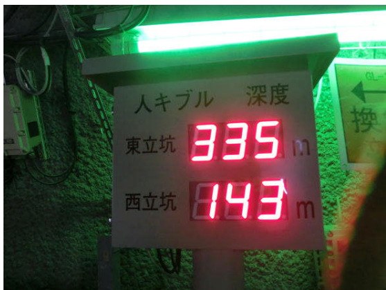
写真6 深度を示す電光掲示板
